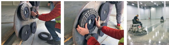
Szybkie szlifowanie i polerowanie za pomocą „zacieraczki”.
