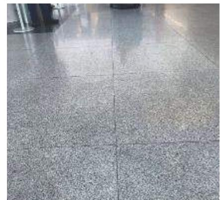
“ПОСЛЕ” НА ИЗОБРАЖЕНИИ ПОЛ ПОСЛЕ 5-7 ПРОХОДОВ ТОЛЬКО С ПОМОЩЬЮ ПОЛОМОЙКИ И НР 800 И НР 1800. ЕЖЕДНЕВНЫЙ КЛИНИНГ ВЫПОЛНЯЕТСЯ С ПОМОЩЬЮ НР 3500 РОЗОВЫЙ ЧТО ДАЕТ ОЧЕНЬ ХОРОШИЕ РЕЗУЛЬТАТЫ И БОЛЕЕ ВЫСOKИЙ БЛЕСК.
