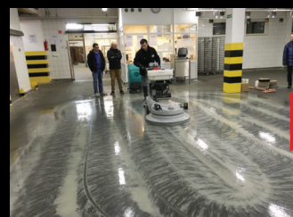
LAVINA FLOOR ECO Technologia honingu, głębokiego czyszczenia posadzki betonowej przy pomocy maszyn planetarnych polerujących.
