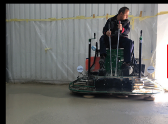
LAVINA TROWEL SHINE Technologia szlifowania, honingu i polerowania betonu przy pomocy zacieraczek do betonu.
